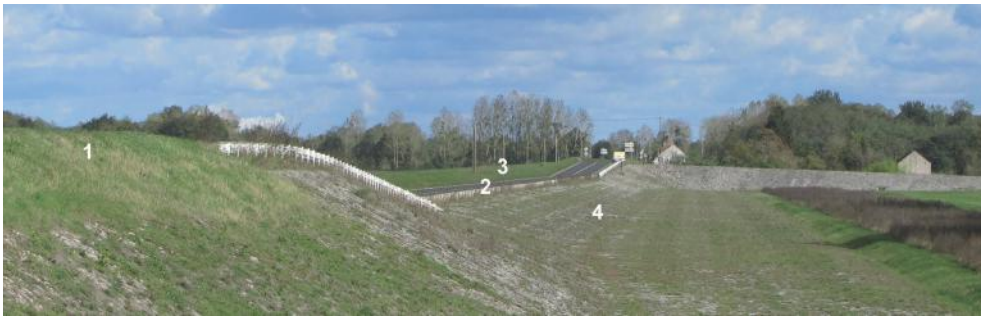
Fig. 15. Déversoir de Montlivault en amont du val de Blois.
