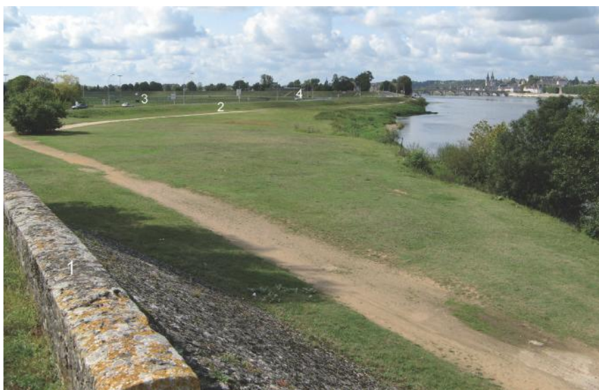
Fig. 10. Vue vers le déversoir de la Bouillie. 1 : levée de la Loire ; 2 : déversoir de la Bouillie (cote du seuil : 71,2 m ; cote de la banquette fusible : 71,5 m) ; 3 : la Boire ; 4 : levée de l'Eperon. Le déversoir, situé juste en amont de la ville de Blois, a succédé à l'ancien « déchargeoir » déjà existant en 1584 et a été remanié à diverses reprises. Destiné à protéger le pont Gabriel et les secteurs endigués en rive gauche et en rive droite de Blois en déviant une partie du débit de la Loire dans le val de Blois, il a essentiellement un rôle de court-circuit.
