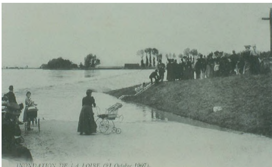
Fig. 11. Crue de 1907, fonctionnement du déversoir de la Bouillie. Aujourd'hui il fonctionnerait pour des crues supérieures à la crue cinquantennale 1 (hauteur de 4,8 m à l'échelle de Blois, débit de 3 900 m 3 .s -1 à Blois).
