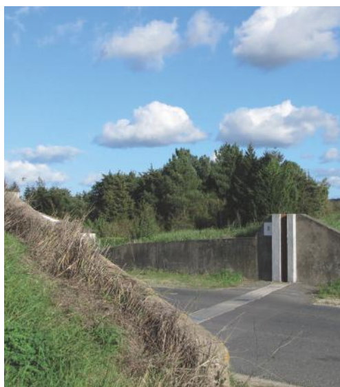
Fig. 13. Levée de Bas-rivière, ouverture obstruée par un batardeau.
