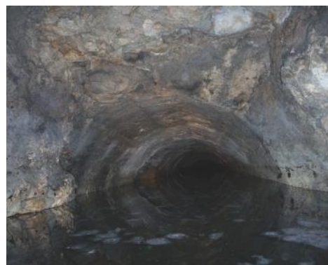
Fig. 8. le Gouffre : salle aval, galerie de départ vers les fontaines. La roche, calcaire de Beauce, est bien visible sur les parois de la salle. La galerie a les dimensions d'un véritable aqueduc. De la calcite* flotte à la surface de l'eau.
