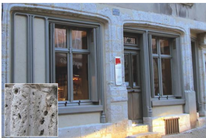
25 rue des Trois Marchands, façade en calcaire de Beauce. Certaines pierres présentent d'anciennes cavités karstiques* (cf. agrandissement).
