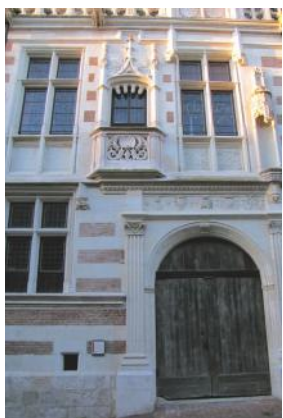
Hôtel d'Alluye. Soubassement en Pierre de Saint-Gervais-la-Forêt ; élévation en tuffeau blanc / Pierre de Bourré ; restauration en Pierre de Tercé (Vienne).
