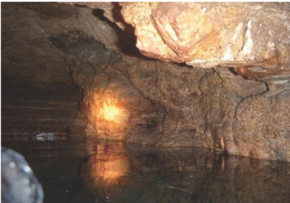
Fig. 2. Galerie principale, au niveau de la rue Bretonnerie. Cette partie de la galerie principale présente une cavité importante permettant de penser que la structure initiale est d'origine karstique*. La hauteur d'eau est ici de 1,25 m. Photo M. CHASSIER - Spéléo-club de Blois.
