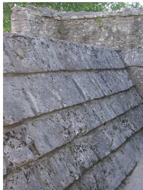
Fig. 6. le Gouffre . Toit de l'édicule en dalles de calcaire de Beauce.
