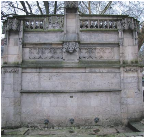
Fig. 11. Fontaine Louis XII, appelée Grandes fontaines jusqu'en 1823. La base est en pierre de Saint-Gervais-la-Forêt (calcaire lacustre* de Beauce), la partie supérieure, à l'origine en pierre de Bourré (tuffeau), a été restaurée avec la pierre de Tercé (Vienne - calcaire marin du Bathonien / Jurassique moyen / -167 millions d'années).
