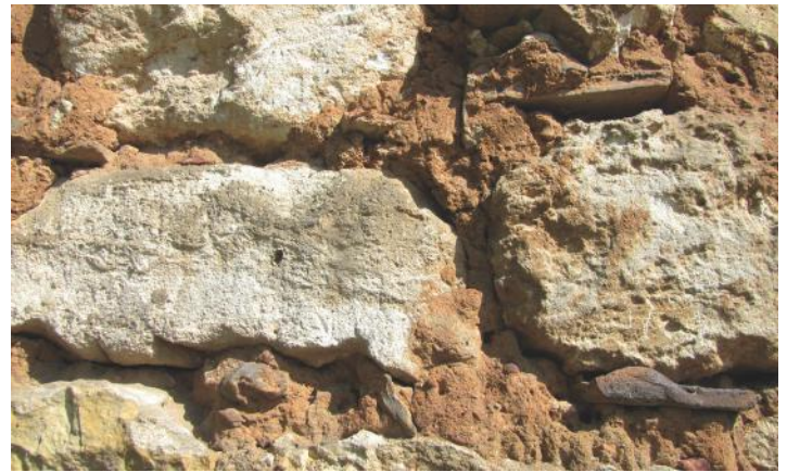
Fig. 15. La craie, le silex et l'argile devenus matériaux de construction.
