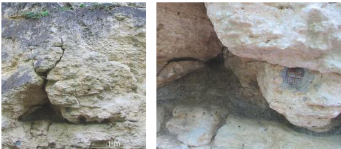
Fig. 7. Cavité karstique* (mur d'escalade, partie sud, voies 67-66). Des lits d'argile superposés remplissent la cavité et les fissures voisines. L'argile entraînée par les eaux circulantes dans les conduits et les cavités du karst* peut avoir diverses origines : - décarbonatation du Tuffeau ou de la Craie blanche/Calcaire de Sasnières sus-jacent, - entraînement de l'argile de l'Argile à silex, elle-même résidu de décarbonatation du calcaire de Sasnières (cf. fig. 3), - ... Cette cavité est située au niveau du joint de stratification inférieur. D'autres cavités sont facilement repérables dans le joint de stratification supérieur et en divers points du mur (voies : 9 / 28-29 / 34-54 / 60-80 / 74).
