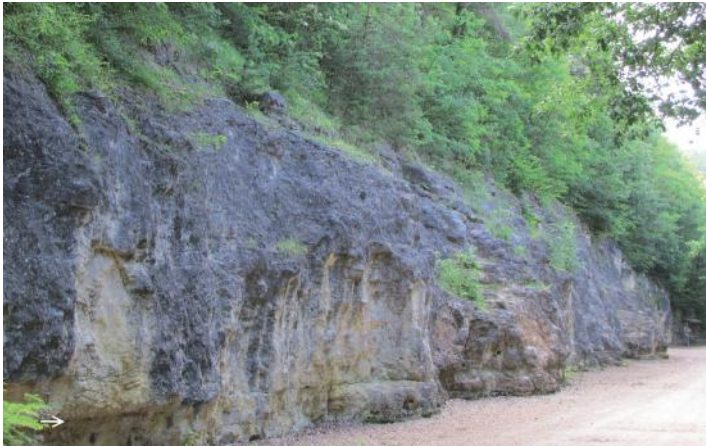
Fig. 4. Mur d'escalade : Tuffeau, partie moyenne du Turonien. Le mur est installé sur le front d'un ancien site d'extraction de tuffeau* ; des caves ont été creusées dans sa partie nord à la Rochette. Le tuffeau*, variété de calcaire à l'aspect de craie, est un dépôt marin. Le front présente des dépôts liés à des courants ou des tempêtes (= tempestites). Certains points en offrent une vision propice : du Nord au Sud, voies 09 / 26-29 / 77-54 / 60-80 / 13-14. Les niveaux bioturbés* (terriers, fouissages...) sont nombreux. La ligne horizontale (flèche blanche), visible à une hauteur de 50 cm sur l'ensemble de l'affleurement correspond à un arrêt de la sédimentation de durée indéterminée. Des silex sont également visibles ; certains correspondent à des terriers silicifiés situés à divers niveaux. Des conduits ou des cavités karstiques de diverses tailles ponctuent le front.
