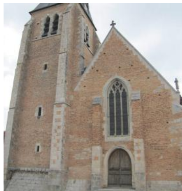
Église Saint-Étienne, Chaumont-sur-Tharonne. Le mariage de la brique et du calcaire. Le matériau calcaire est du calcaire de Beauce importé.
