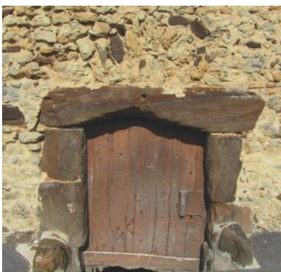
Sargé-sur-Braye, rue de Saint-Martin : entrée de cave.
